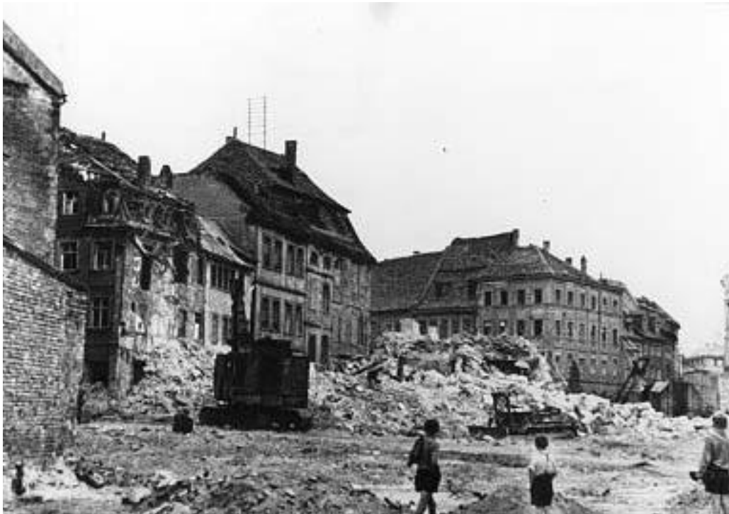
[M1: August 1945: Aufräumungsarbeiten im Bereich Austraße / Grüner Markt; StadtAB, B.S. 333]
